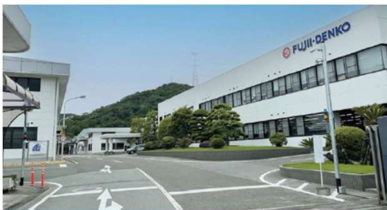
藤井電工株式会社様 本社・滝野工場
